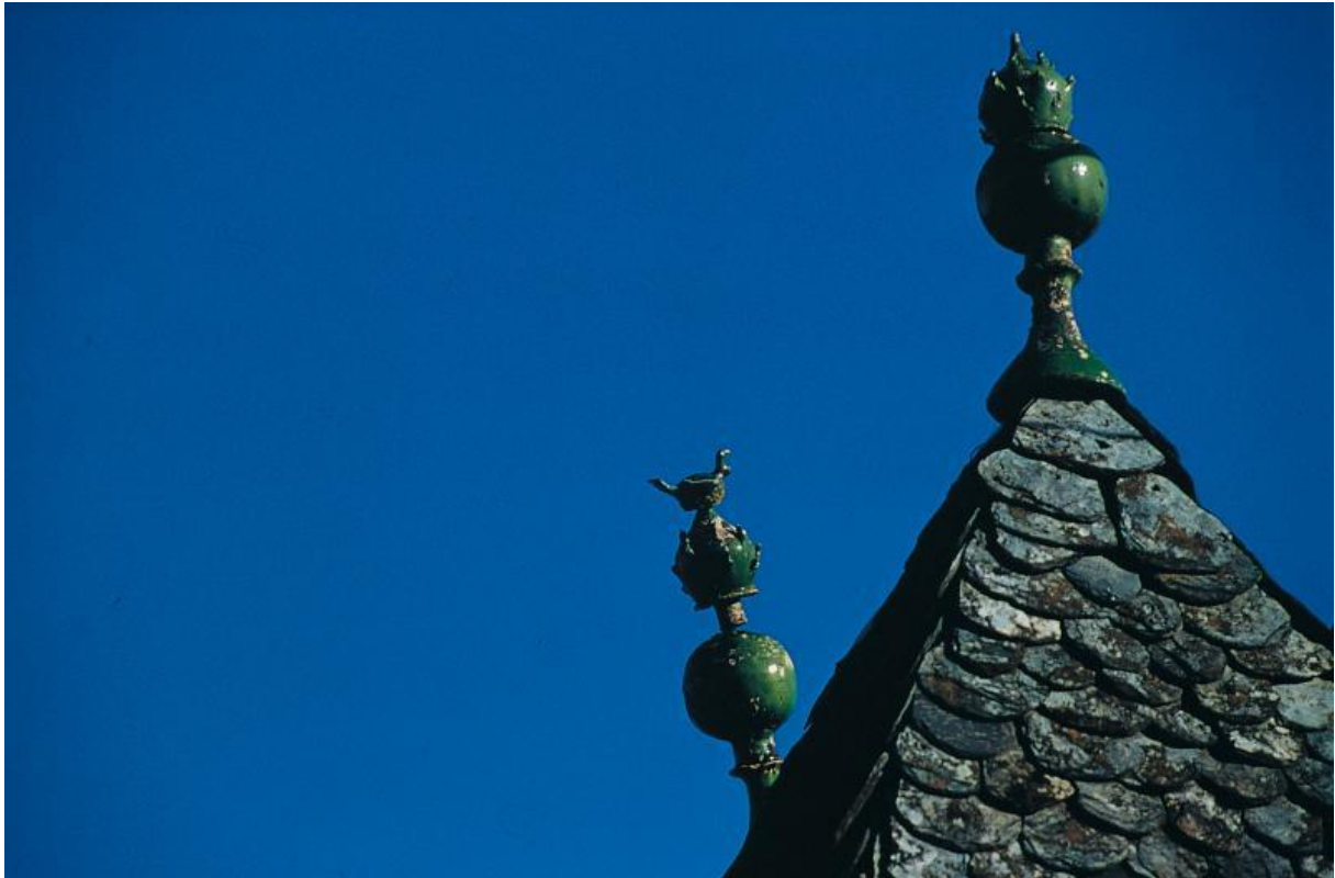
Deux épis de faîtage en terre cuite vernissée dont un avec représentation d'un oiseau, secteur de Laissac.
