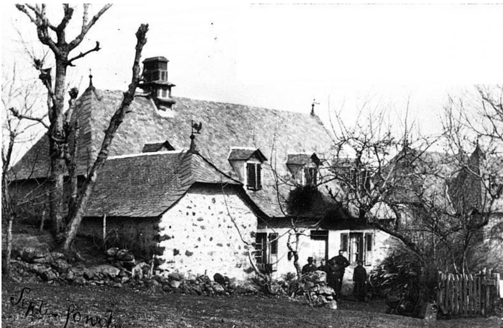
Maison dans la commune de Thérondeles, la toiture comporte 3 épis de faitage.
